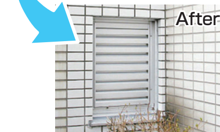
外壁タイルの汚れ洗浄後
