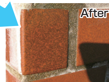
レンガ調のタイルに付着したエフロ洗浄後
