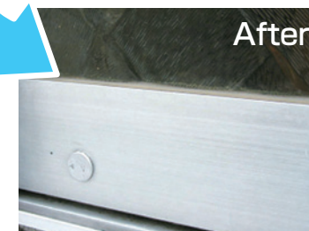
アルミの汚れ洗浄後
